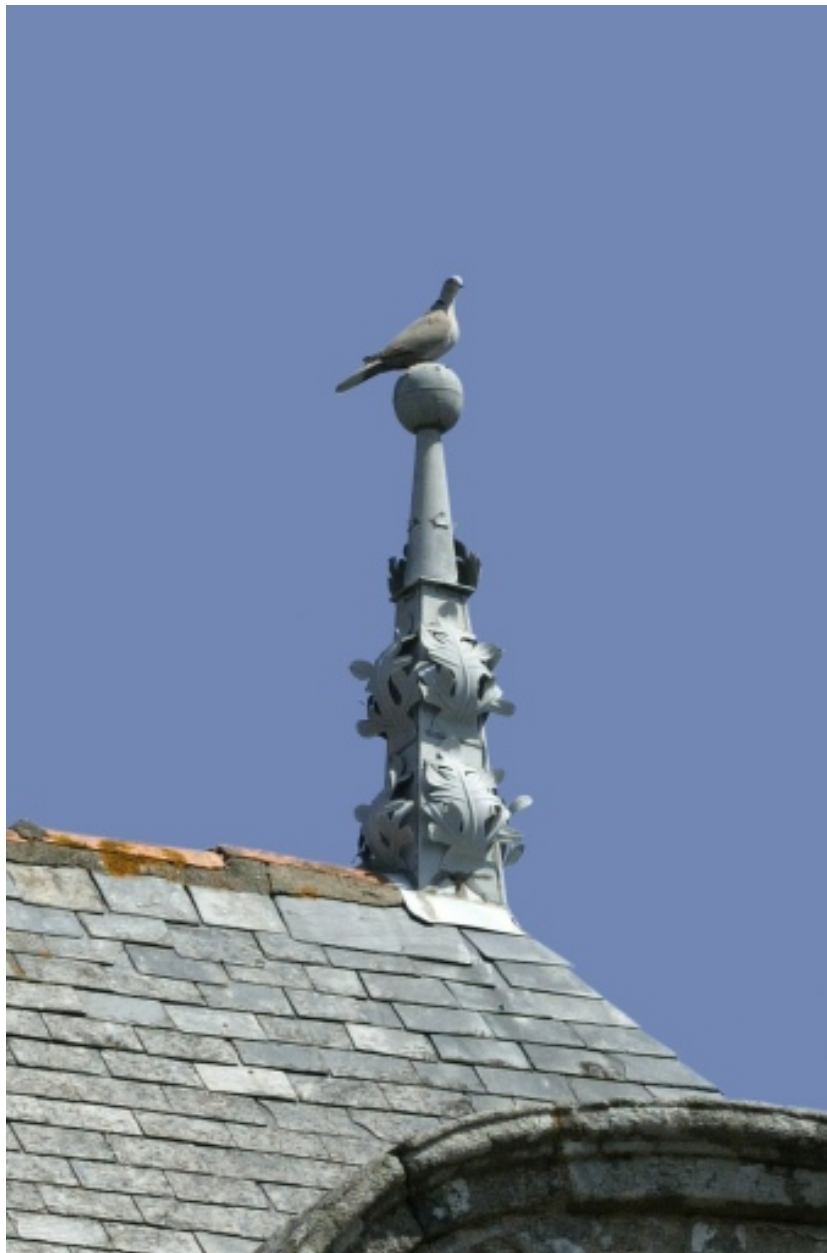
Hôtel de Kerhué, détail d'un épis de faîtage.
