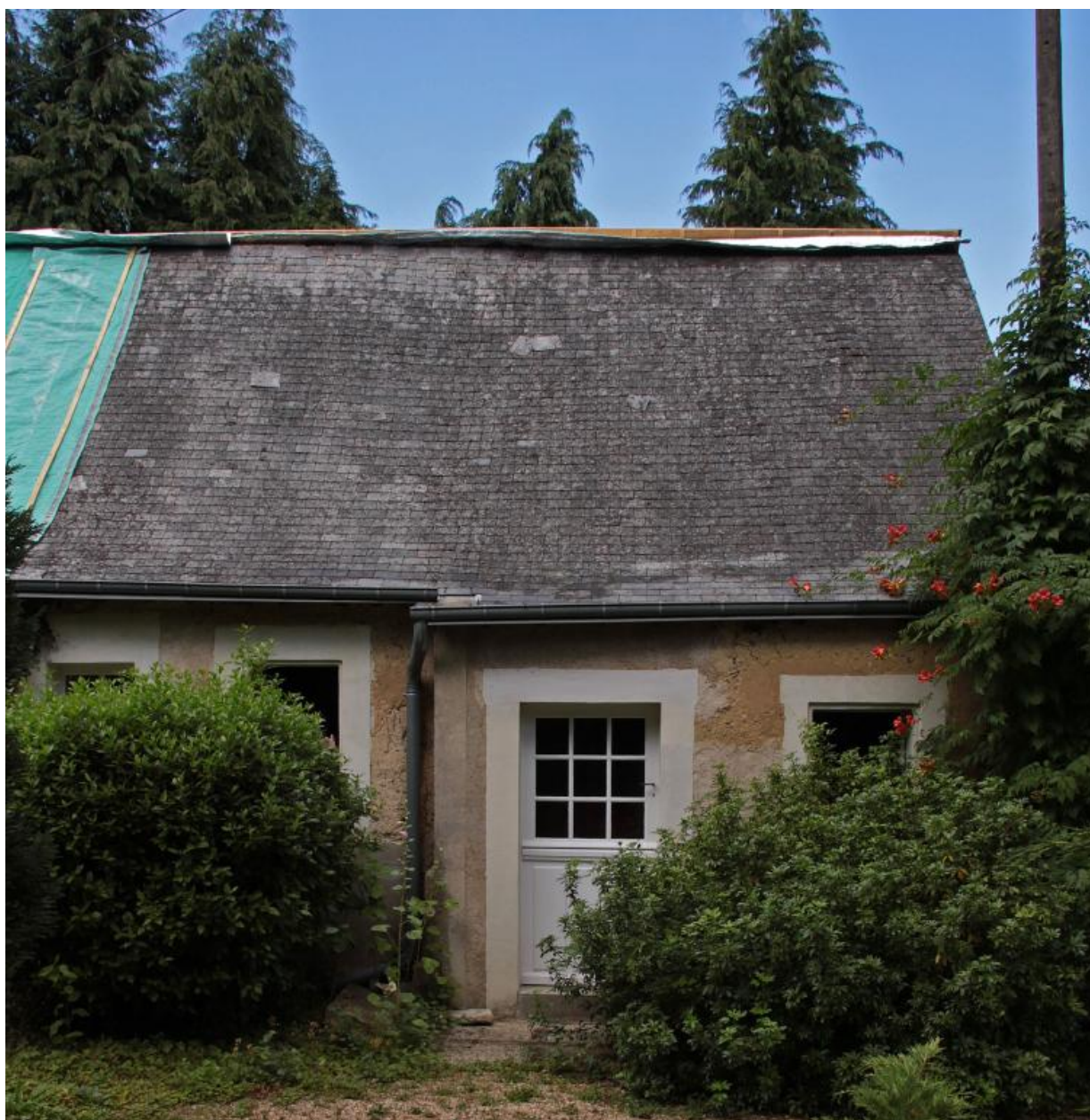
La ferme n°13, les étables transformées : détail.
