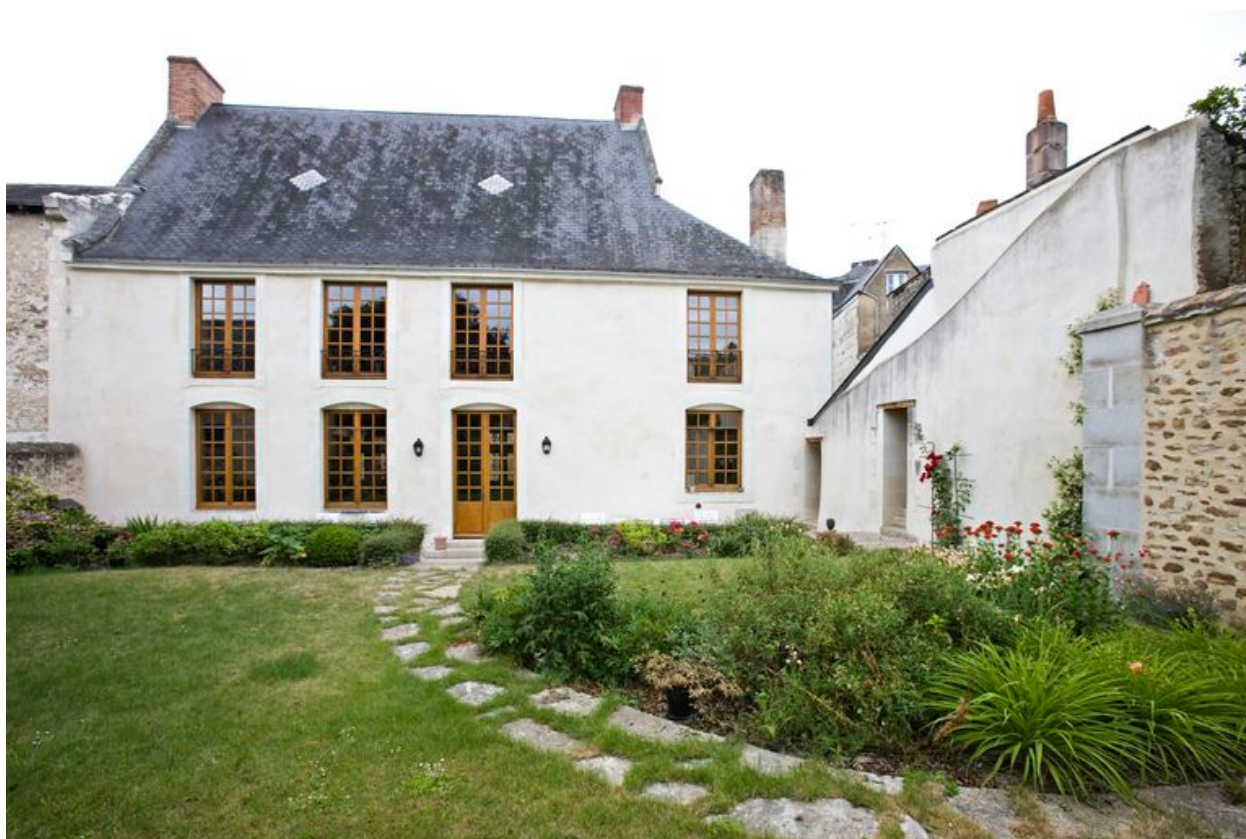
Le logis principal : façade postérieure sur le jardin.
