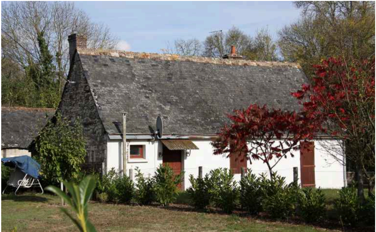
Maison, parcelle 53 : façade antérieure à l'ouest.
