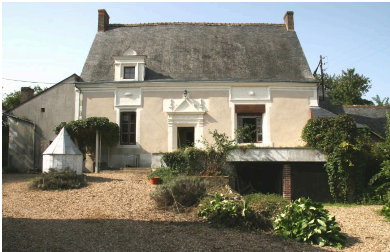
Façade antérieure sur cour.
