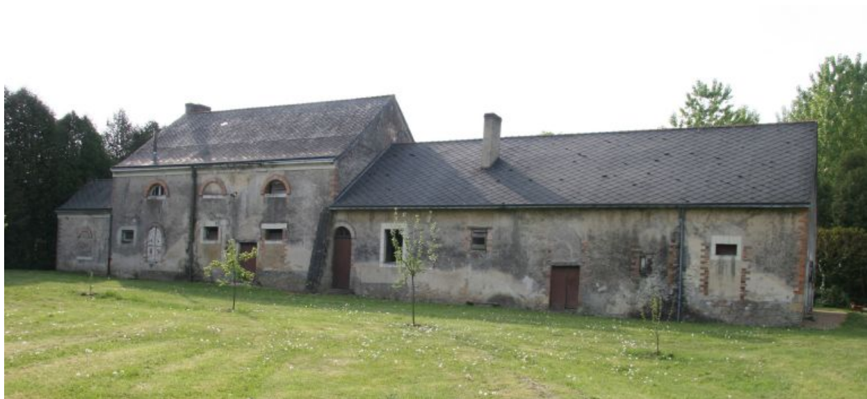
Façade postérieure de l'ensemble des bâtiments.
