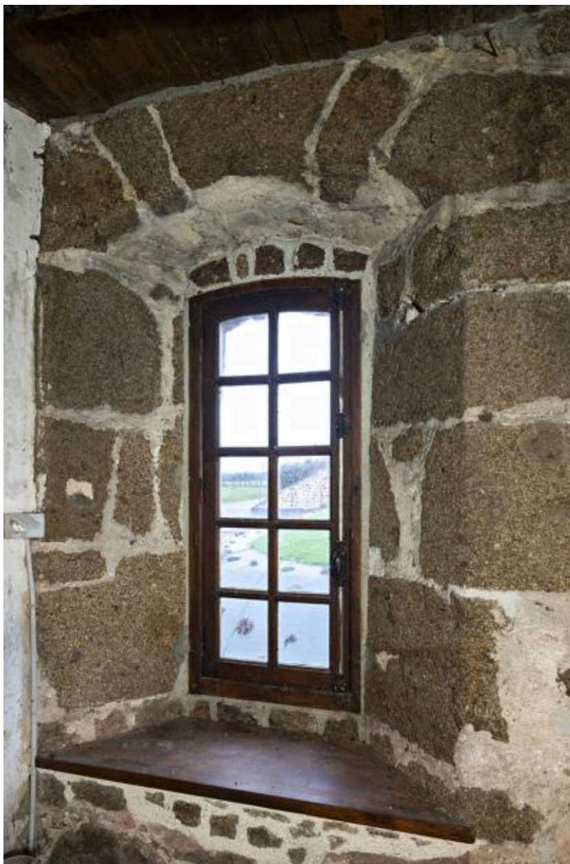
Ebrasement de la baie en tiers-point de la façade nord.
