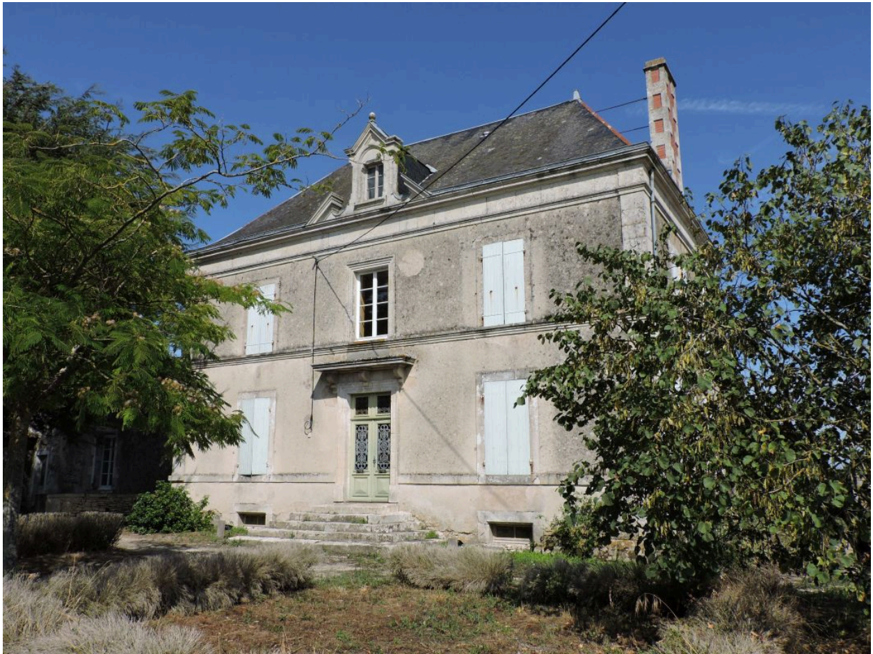
Le logis vu depuis le sud-ouest.
