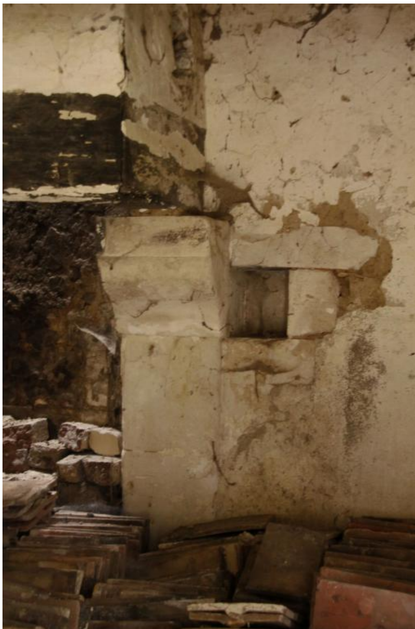
Logement 1 : détail de la cheminée.
