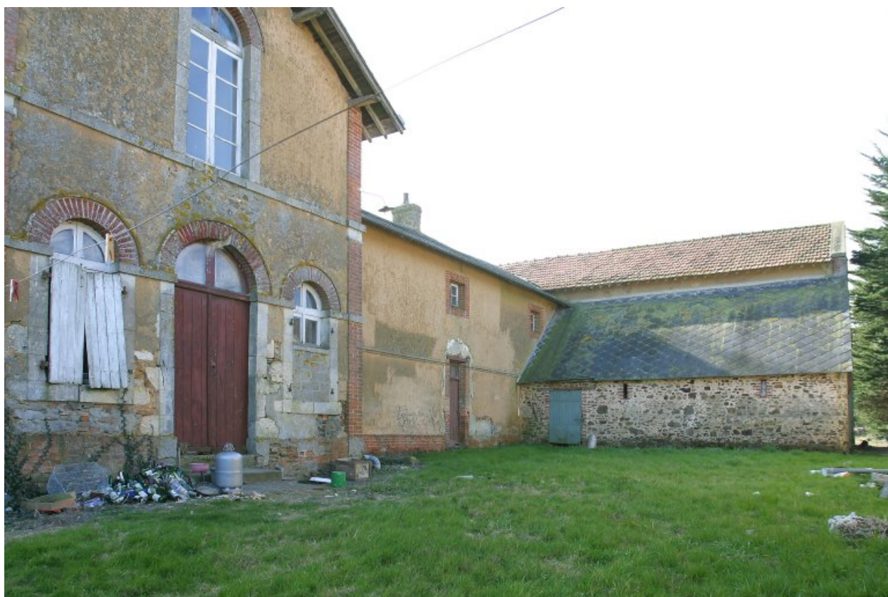
Le logis-écurie. Élévation postérieure vue depuis le nord. Au fond, l'écurie.
