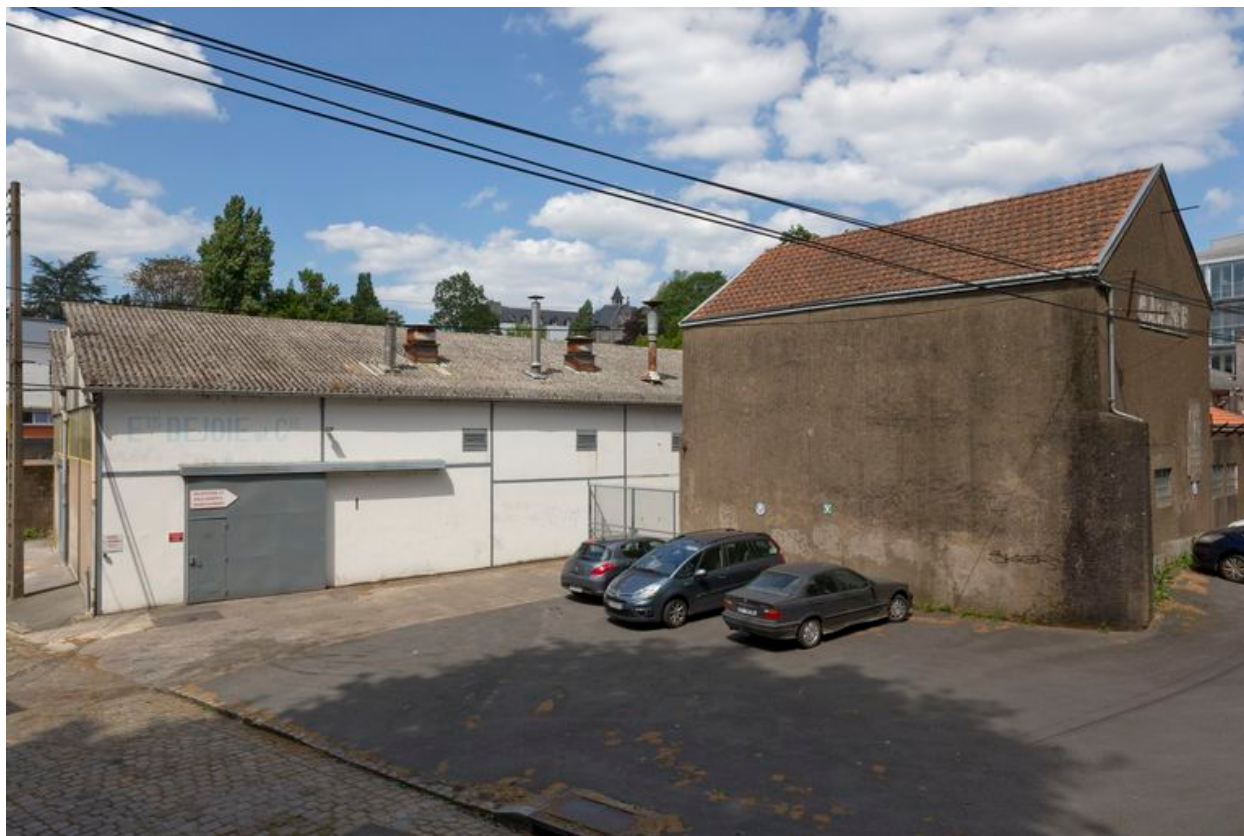
4 et 5 : fonderie-chaudronnerie (à gauche, ancienne huilerie Pelletreau) et magasin de stockage (à droite, ancien garage Bernardin).
