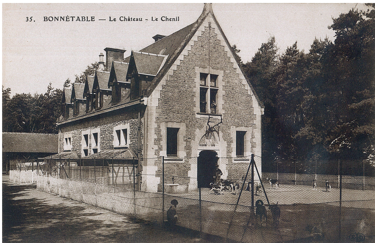
Le chenil de La Lande, vu dans le 1er quart du XXe siècle.
