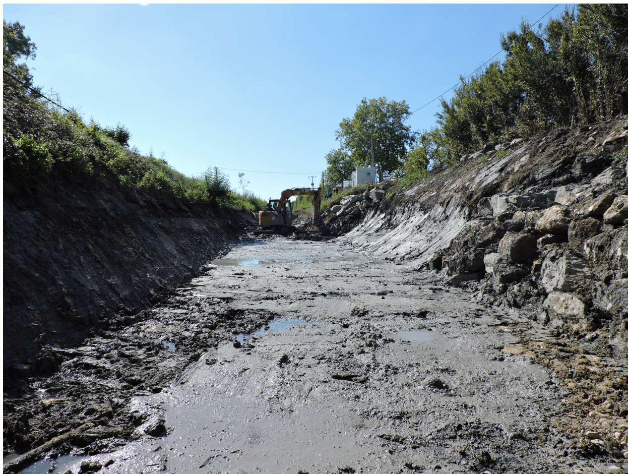
Août 2020 : le canal de Vix en aval de l'aqueduc, curé.
