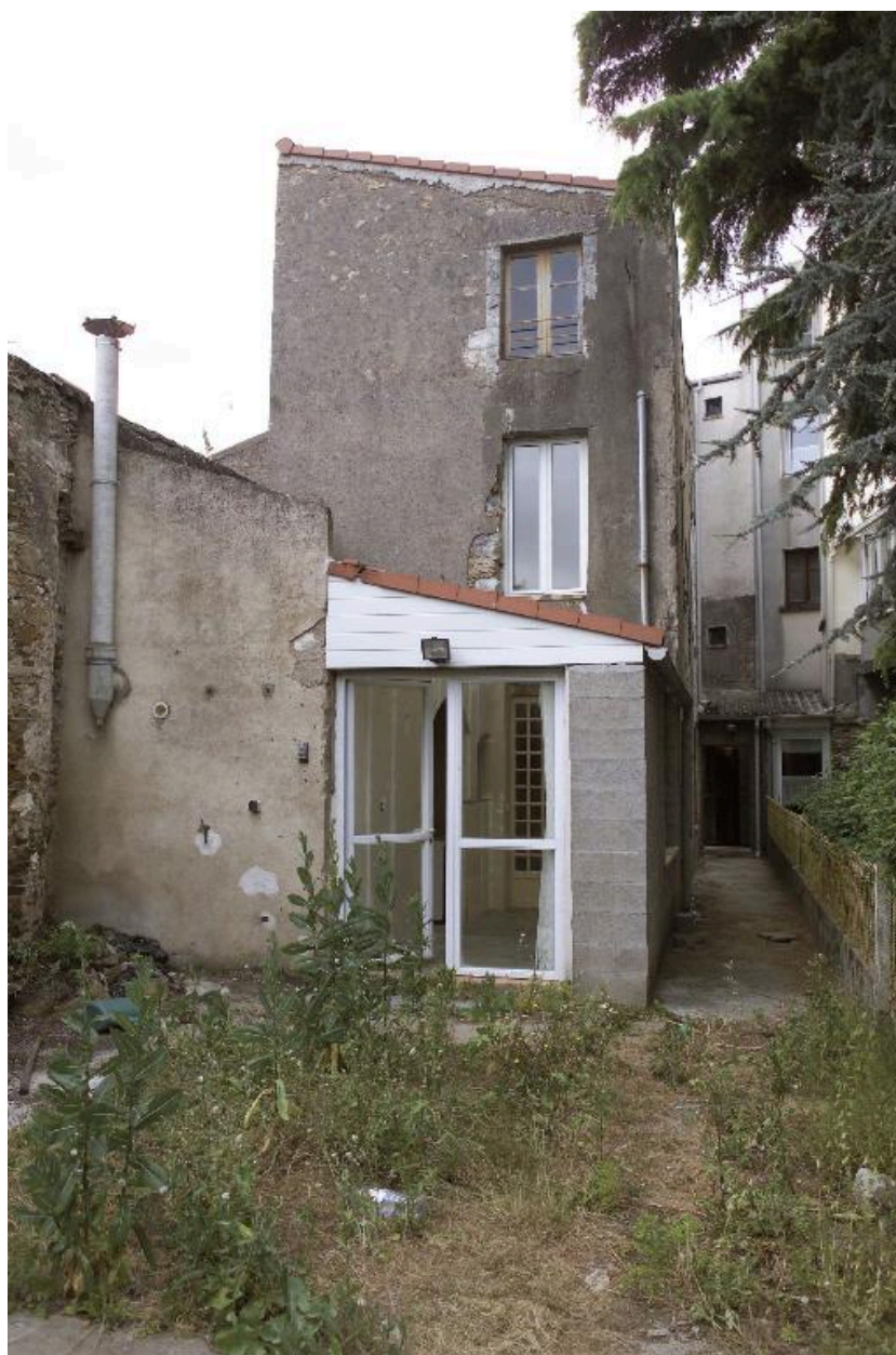
Le pignon du corps secondaire, vue prise du jardin.
