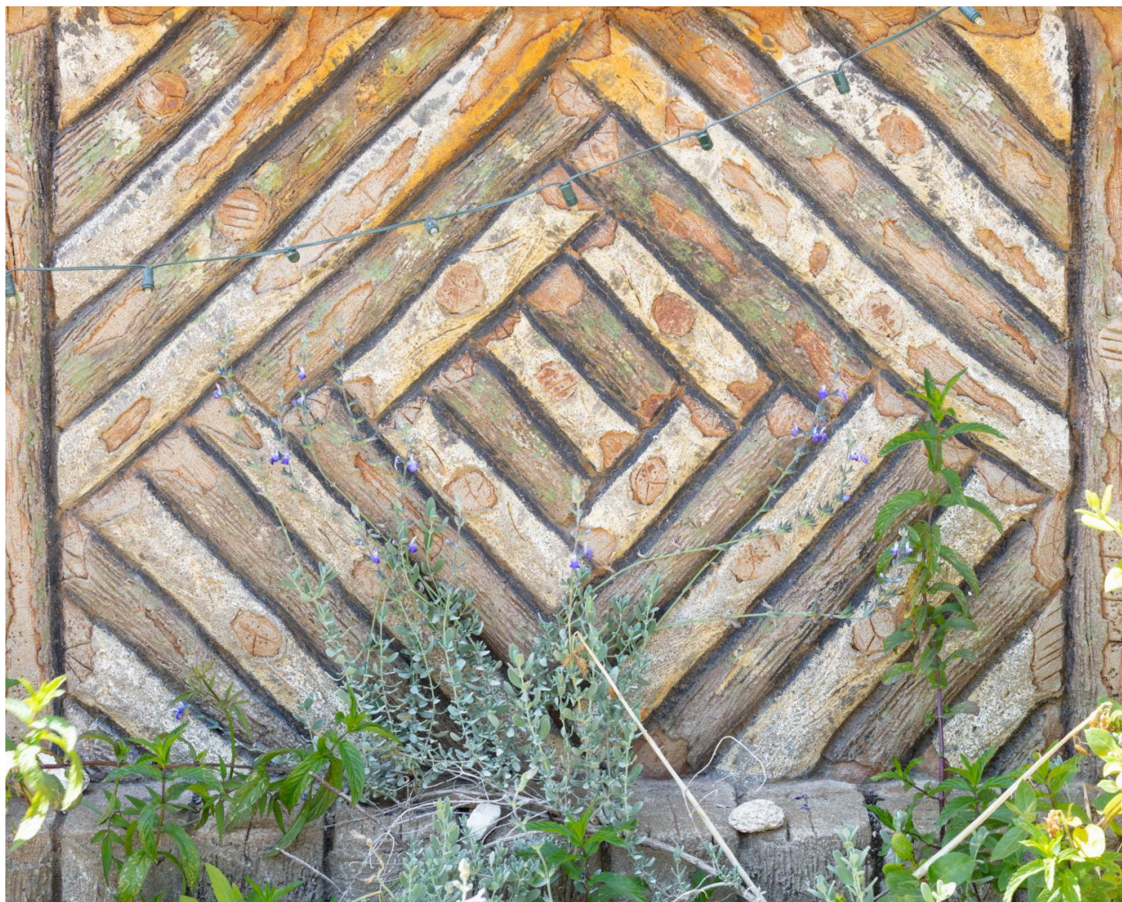
Détail du motif en tronc sur la façade sud.
