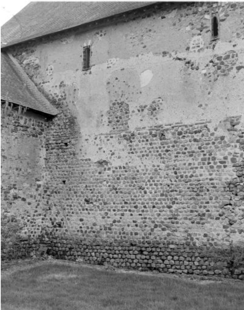
Elévation latérale nord, vue de détail : appareil.
