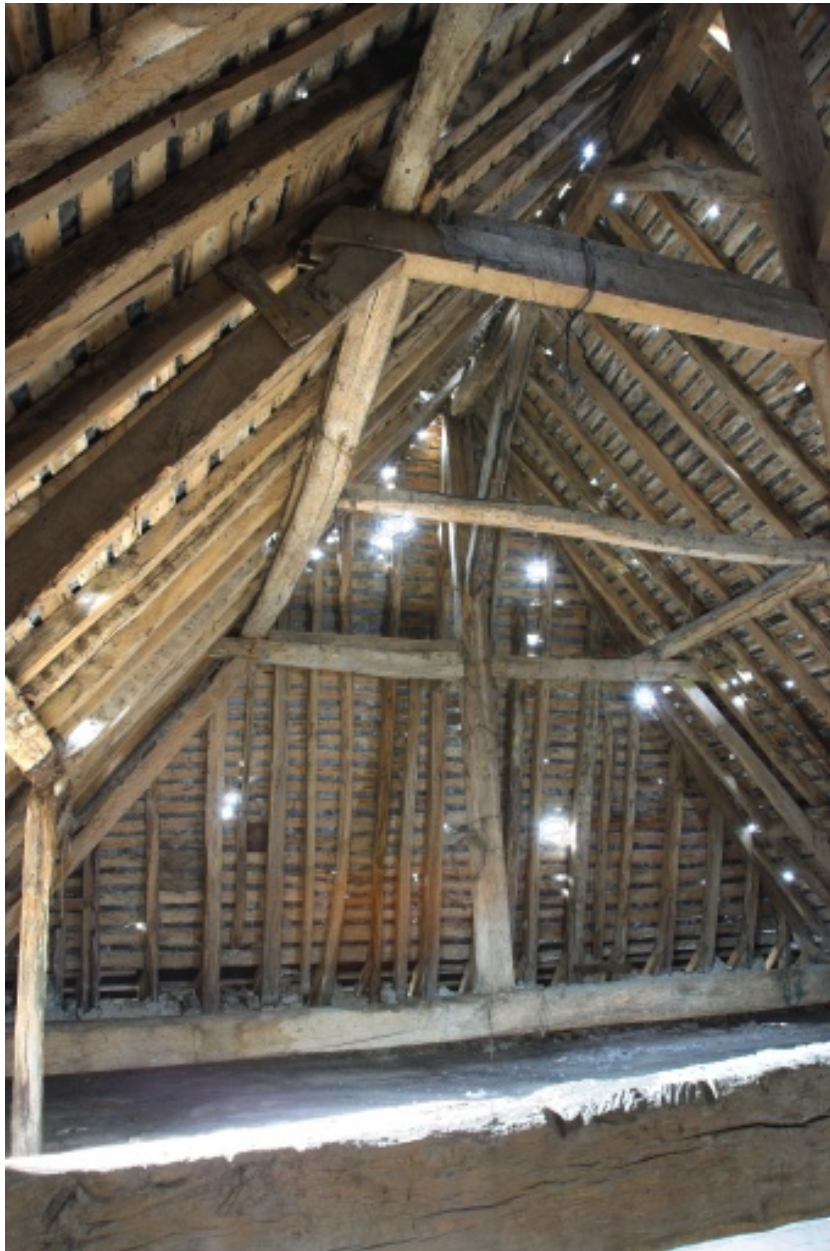
Comble du corps sud : la charpente vue depuis le nord.
