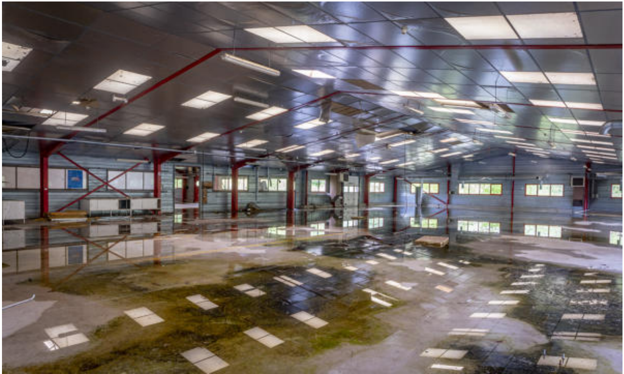
Intérieur des ateliers métalliques H.
