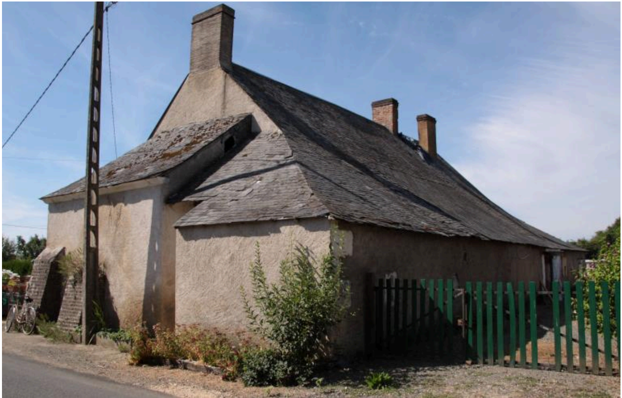
Maison n°9 : vue de volume de la façade postérieure prise depuis la route.
