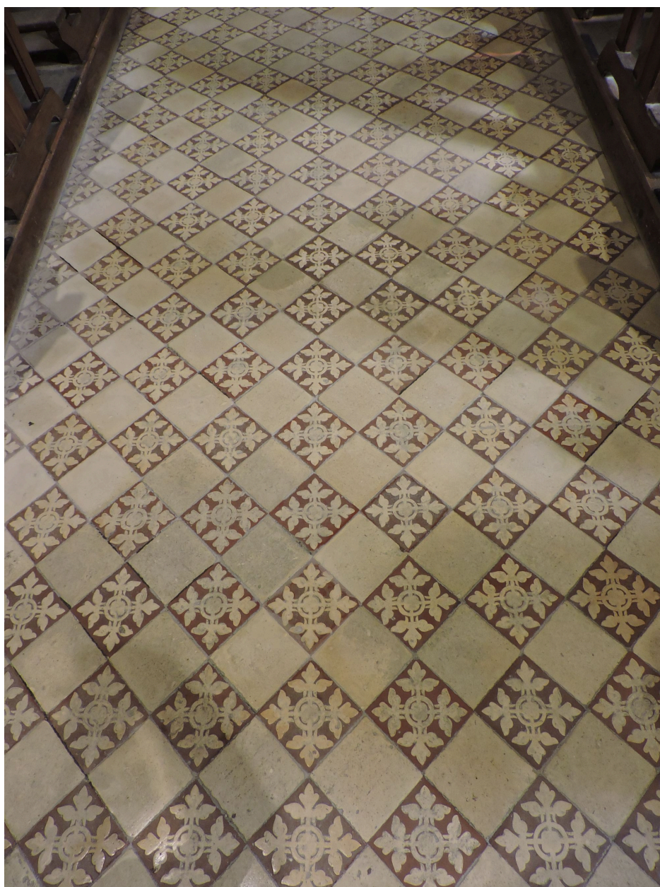
Le pavement de la nef.
