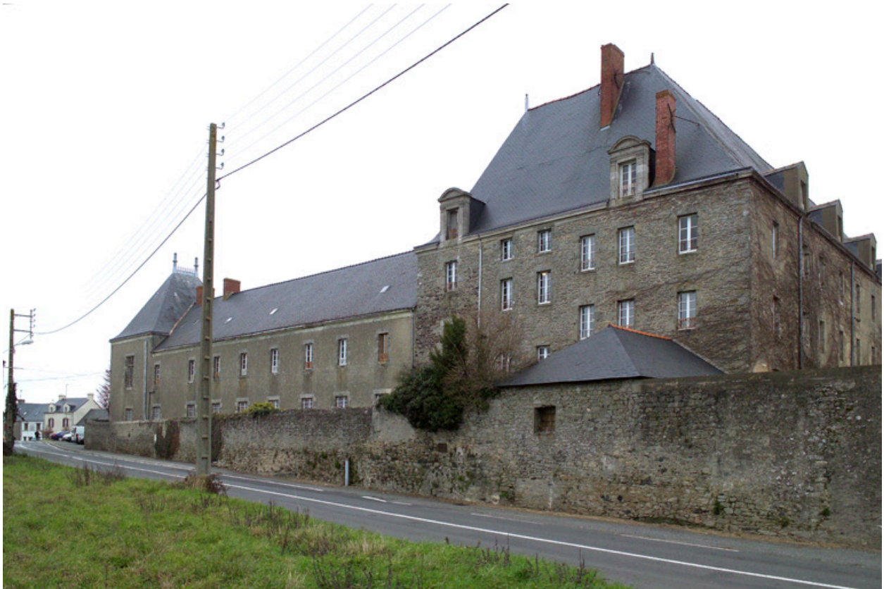
Vue générale de la façade sud.
