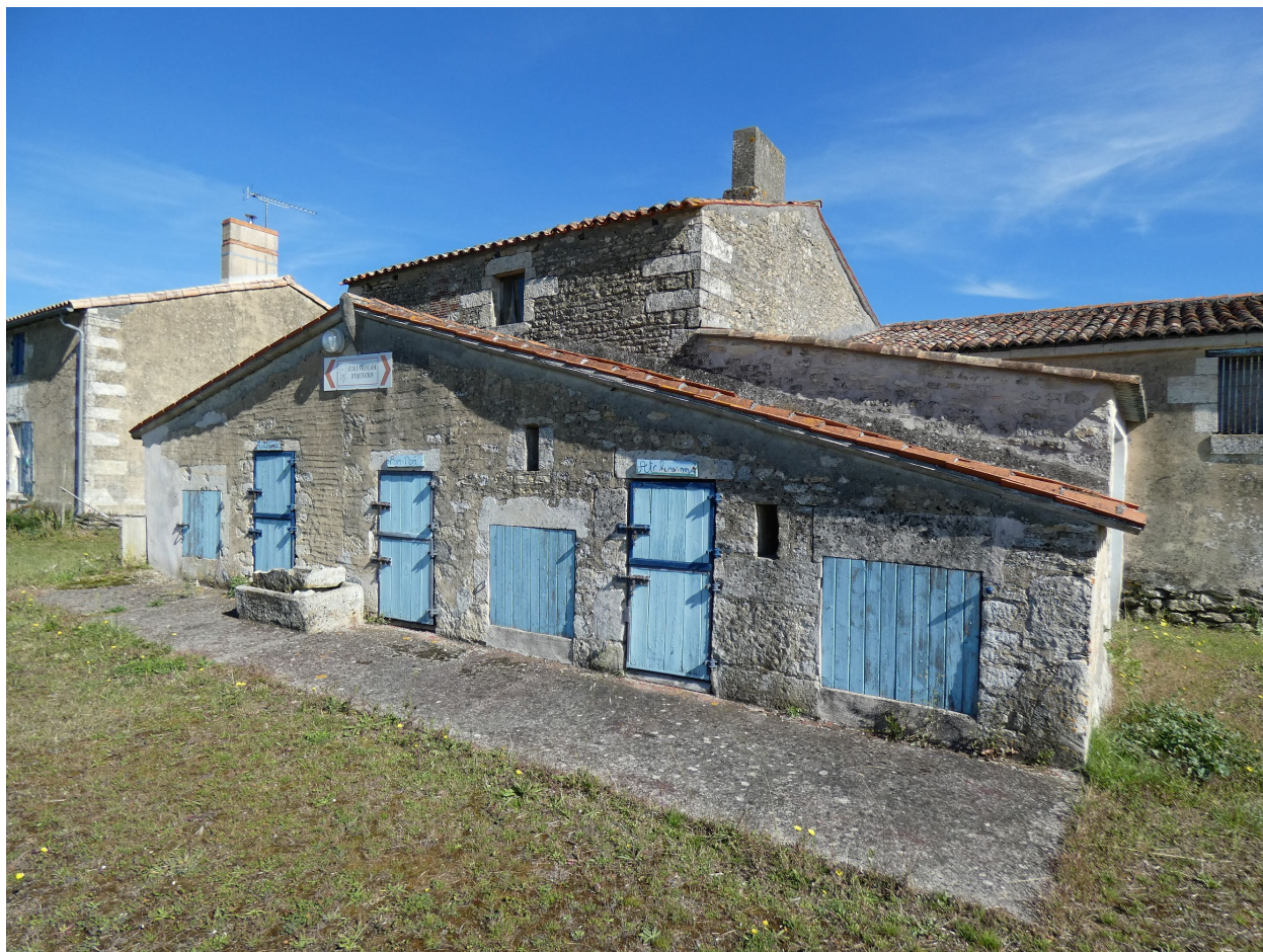
Le toit à porcs vu depuis le sud-ouest.
