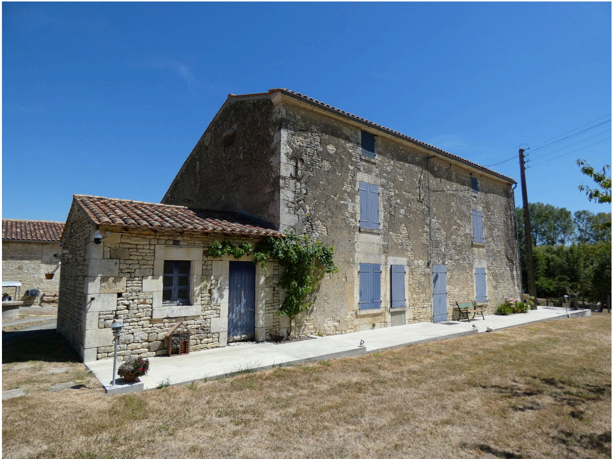
Le logis et le fournil-buanderie à gauche, vus depuis l'ouest.
