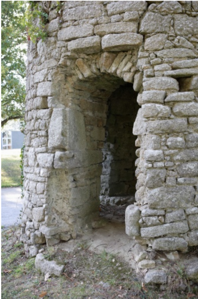
Porte sud-ouest donnant accès à la cavité centrale de la tour.
