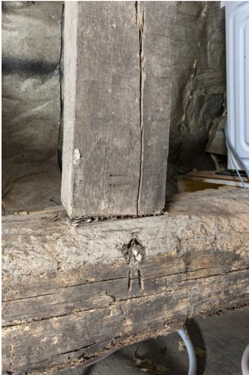
Ensemble 2, logis sud, charpente, ferme nord détail.
