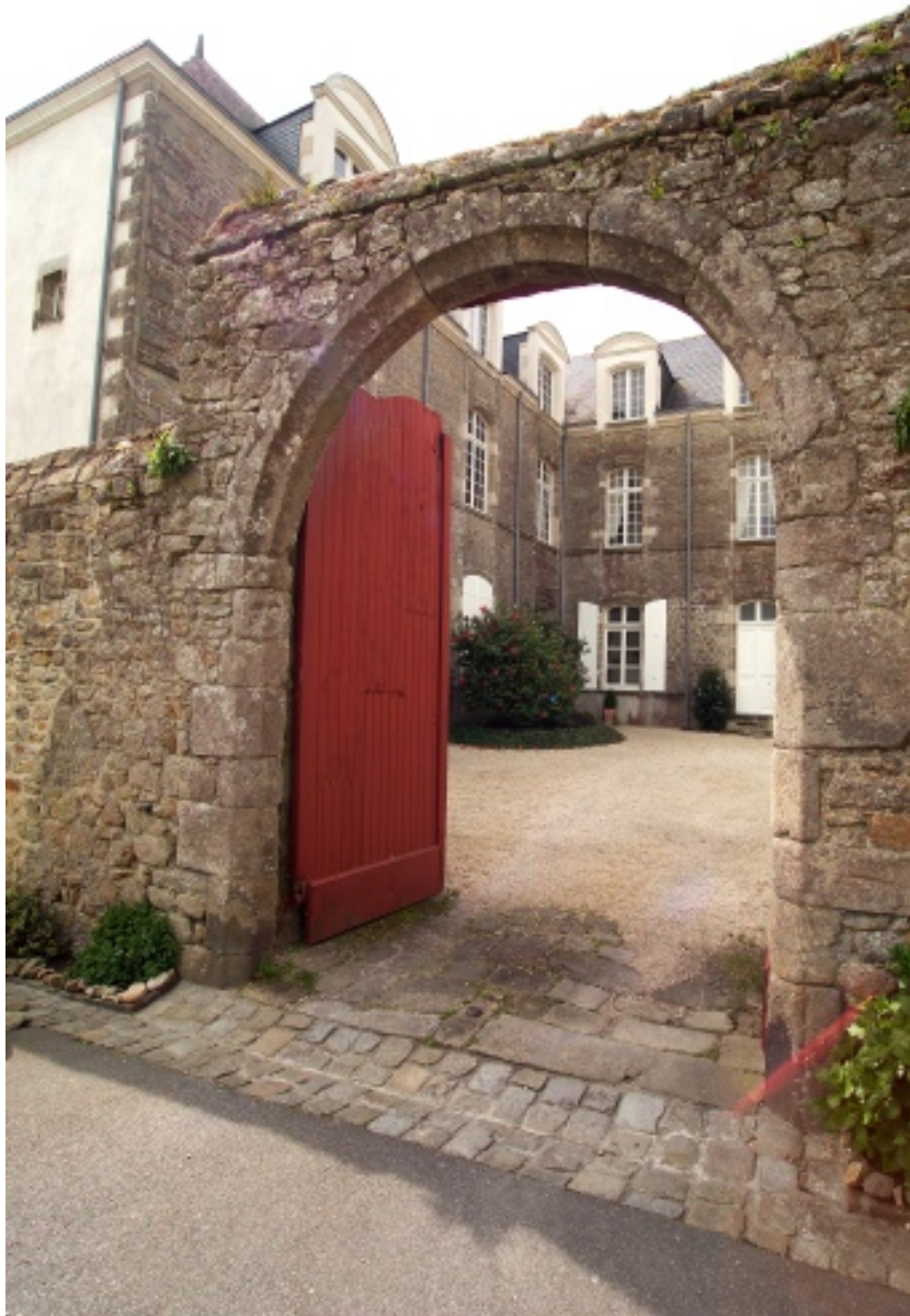
Vue de l'hôtel et du portail depuis la rue du Tricot.
