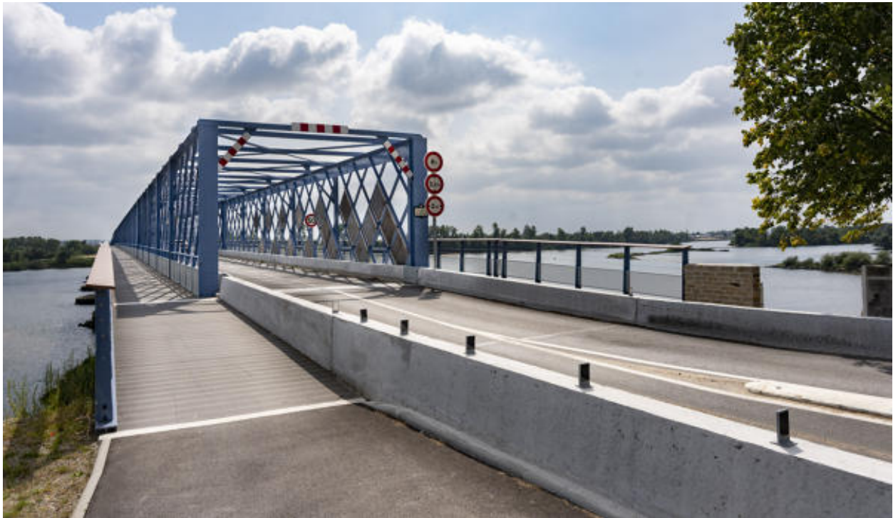
Vue de l'entrée du Grand Pont de Thouaré après les travaux de restauration.
