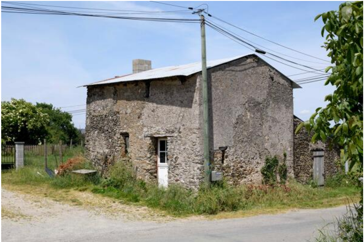
La Jolivetière. Vue de la ferme n° 2 depuis l'ouest.
