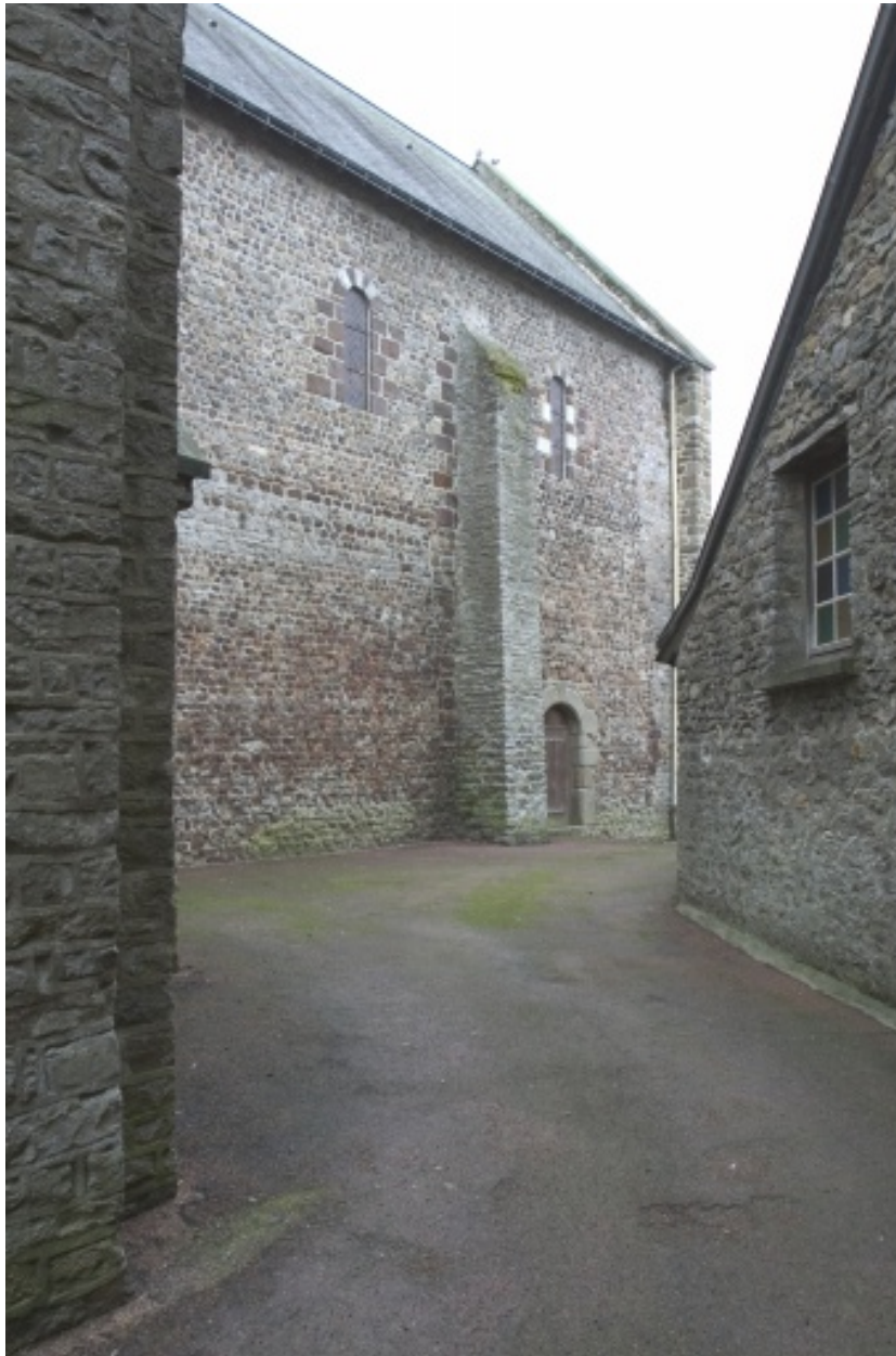
L'élévation nord de la nef vue depuis la ruelle entourant l'église.
