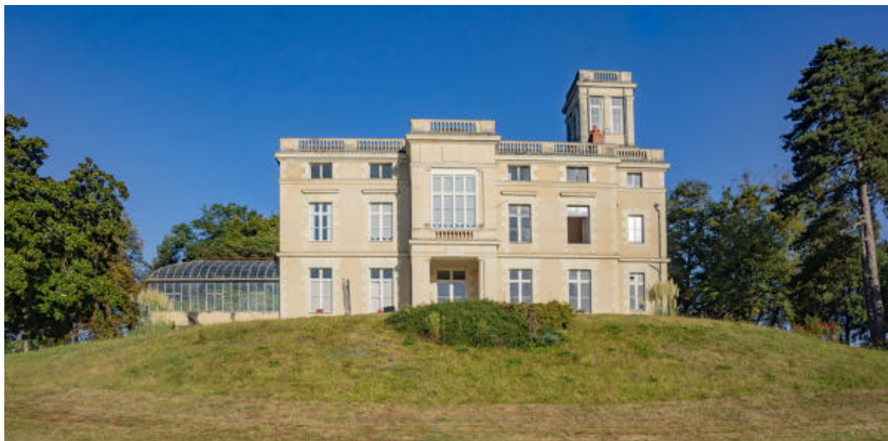
La façade antérieure du château.
