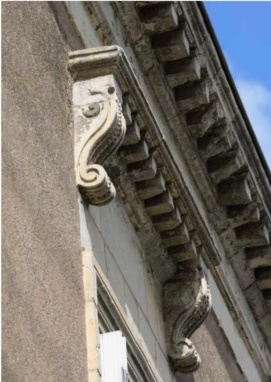
Détail du décor d'une baie, 2 rue de Vendée.
