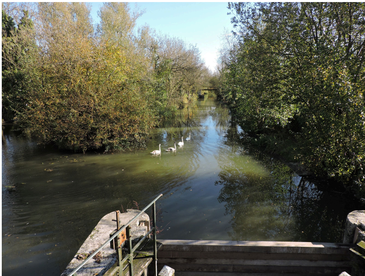
Le canal de Bourneau en amont du barrage éclusé du port de Maillé.
