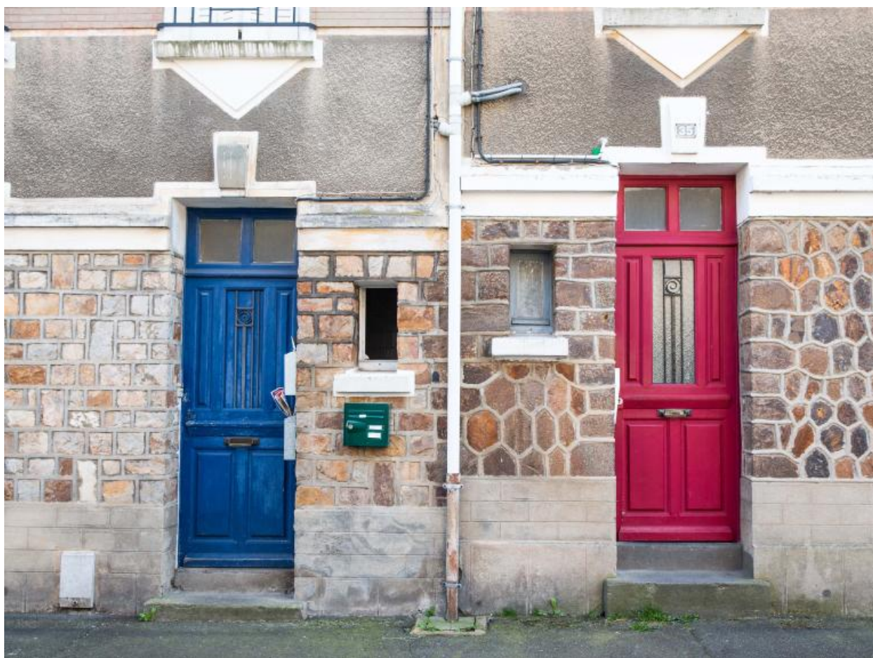
Vue de portes piétonnes de deux immeubles collectifs rue Joubert.
