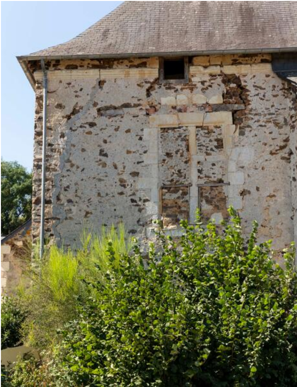
Une fenêtre murée de la façade postérieure.
