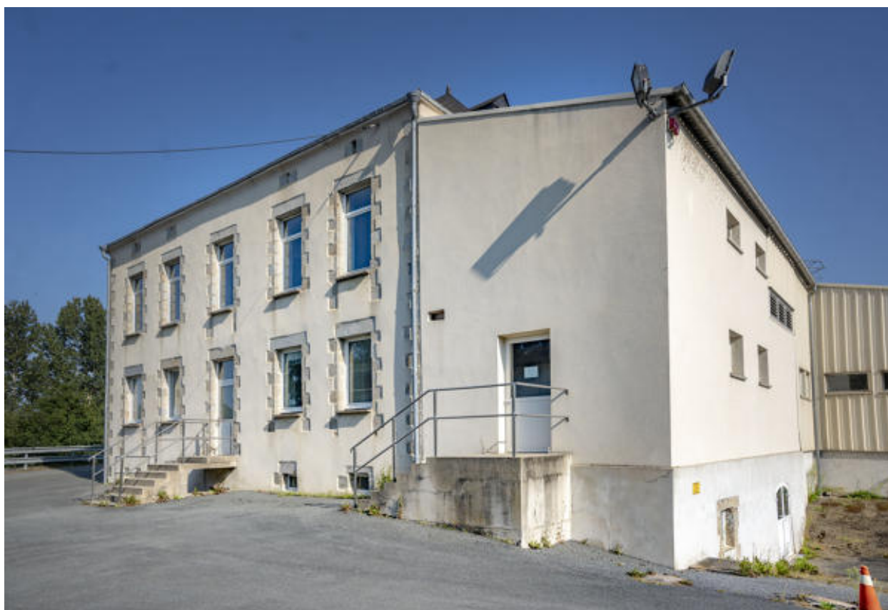
La façade postérieure de la maison.
