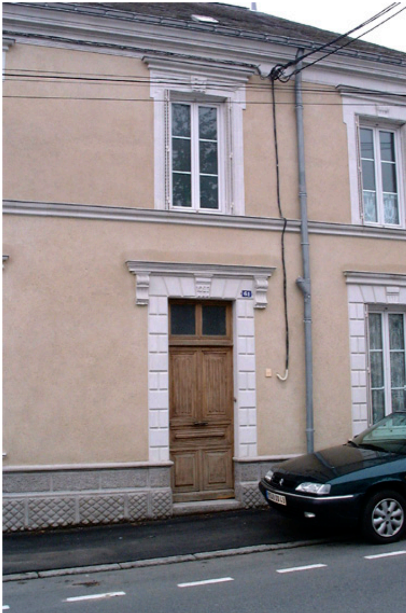
Détail de la façade : porte et fenêtre avec encadrements de tuffeau.
