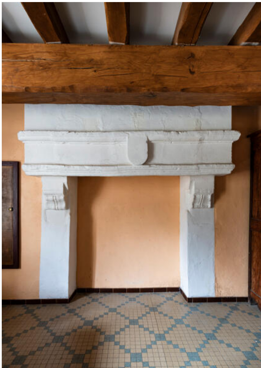
Cheminée de la pièce de gauche du rez-de-chaussée.
