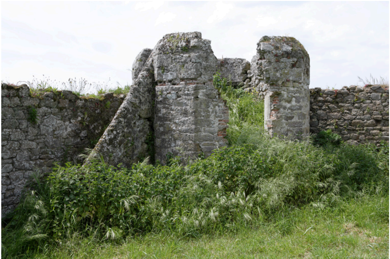
Cour. Vue de la tour octogonale depuis le nord-est.
