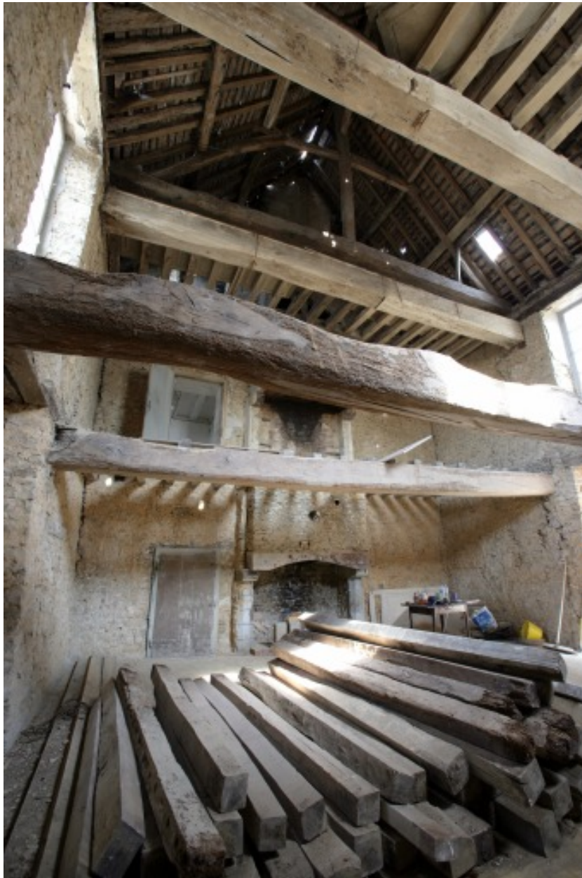
Intérieur du corps sud pendant les travaux : vue d'ensemble depuis le sud-ouest.
