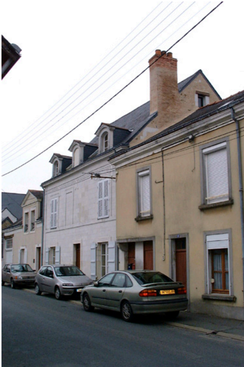
Maison. 18e siècle. Remaniée au 19e siècle.
