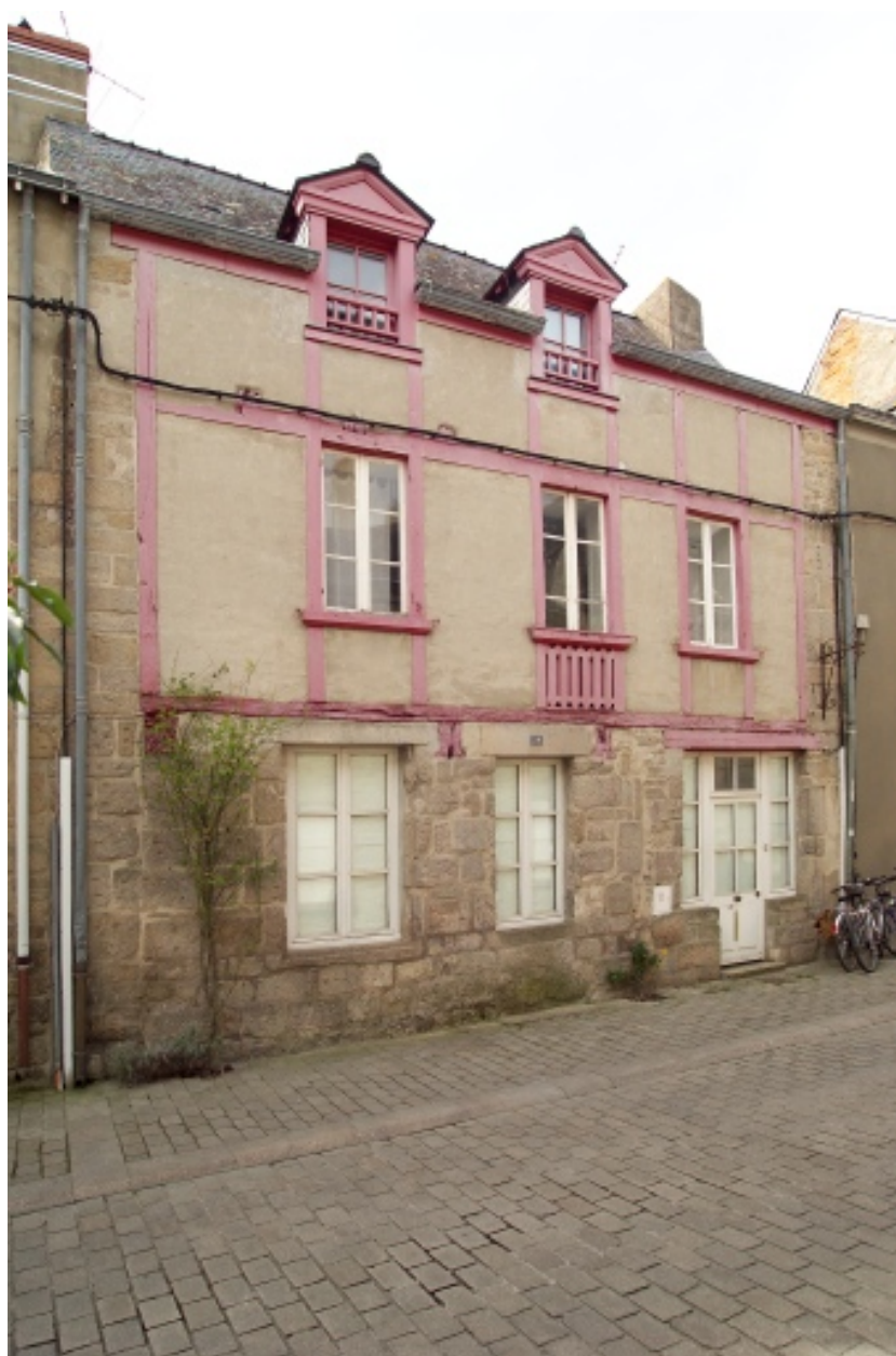
Vue de la façade sur rue.
