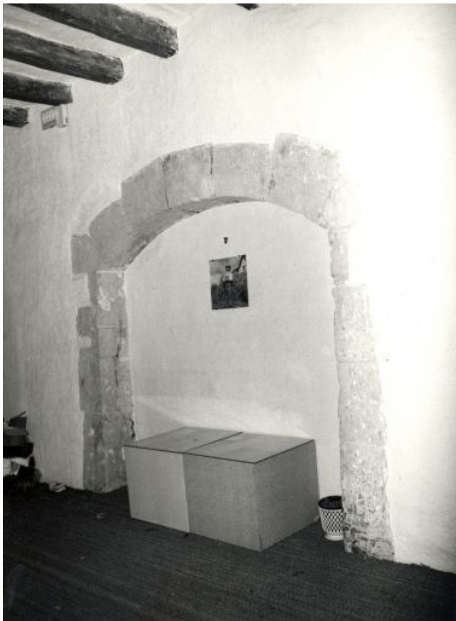
2e étage, pièce antérieure, mur droit.
