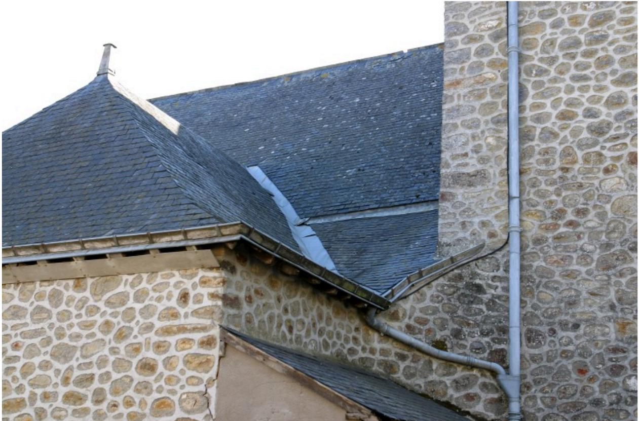
Détail de l'élévation nord : raccordement des toitures du chevet et de la sacristie.
