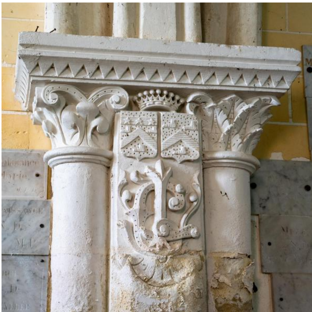
Un détail d'un pilier engagé supportant les voûtes.
