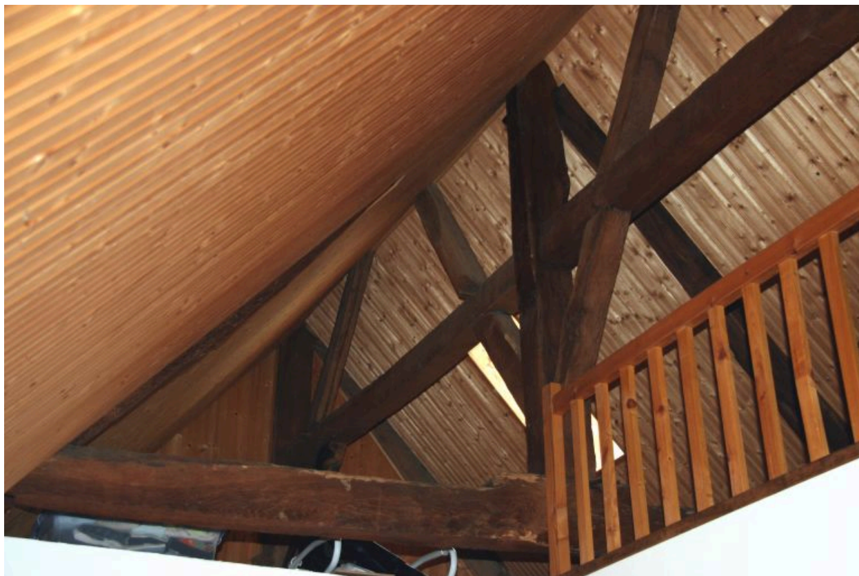
13, rue Principale, maison : charpente à pannes avec sous-faîtage.
