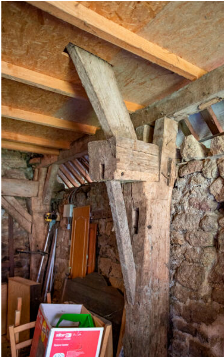
Vestiges de structure à poteaux porteurs (bâtiment 2).
