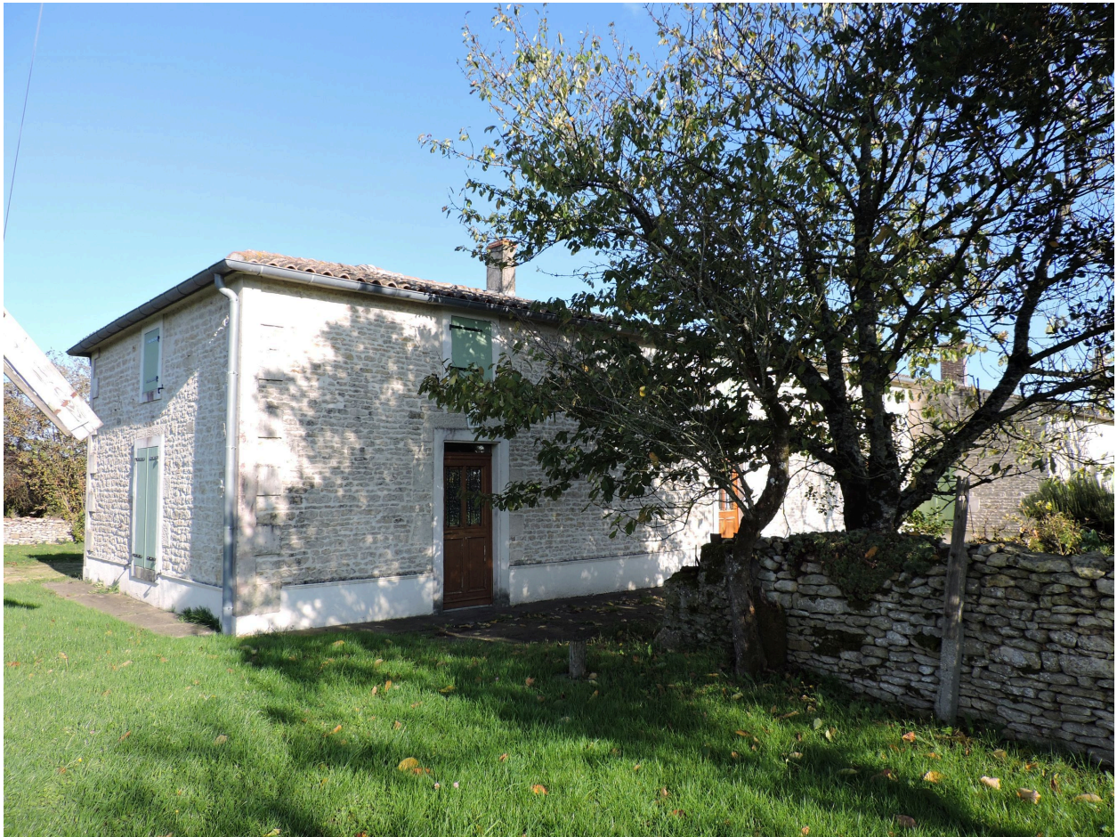
Le logis vu depuis le sud-ouest.
