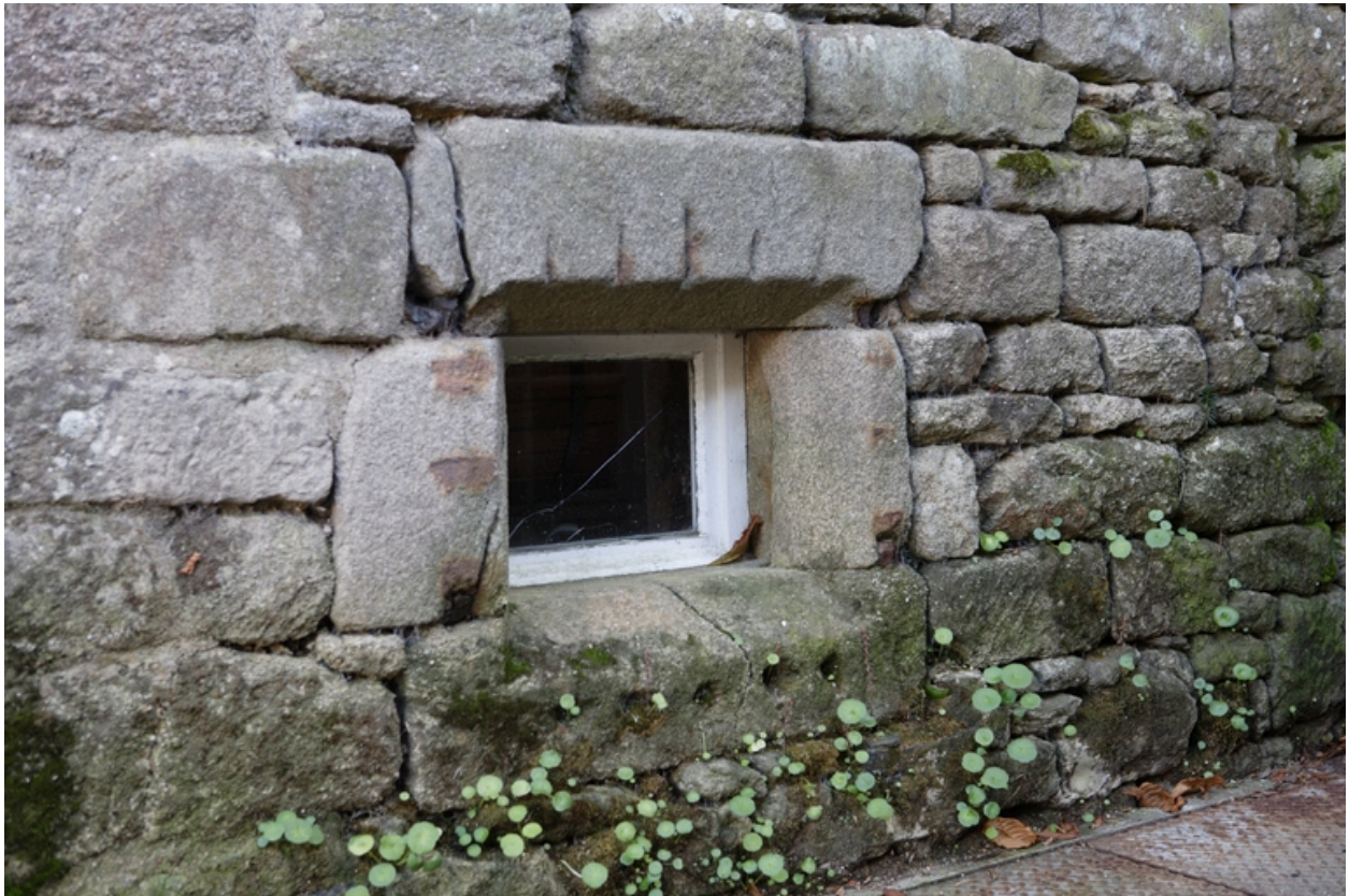
Logis. Cave. Détail du soupirail.
