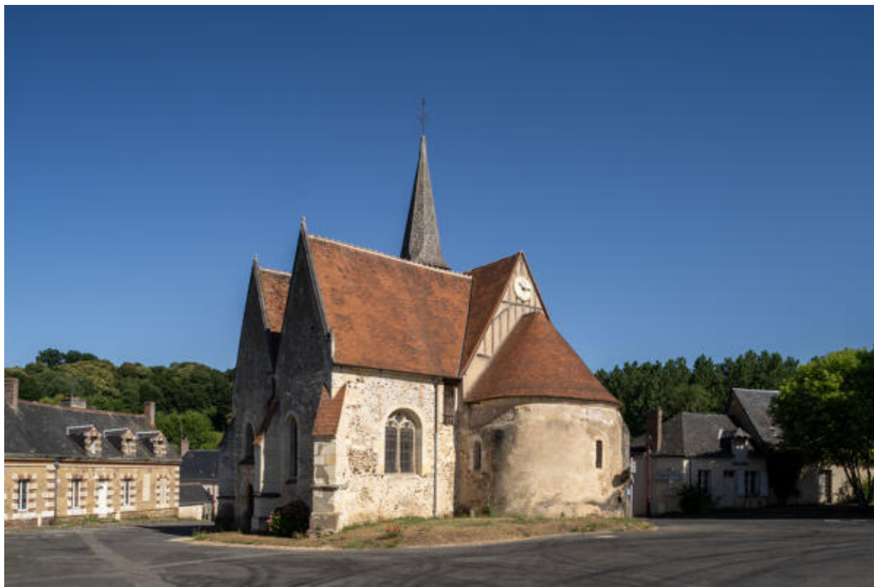
Vue d'ensemble côté sud-est.
