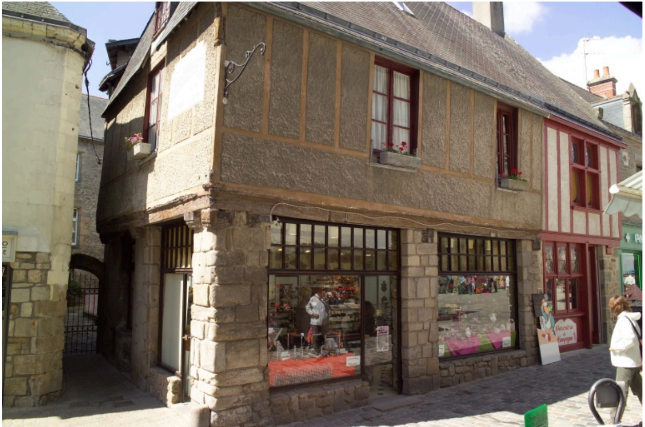
Vue générale de la façade nord et du pignon oriental.
